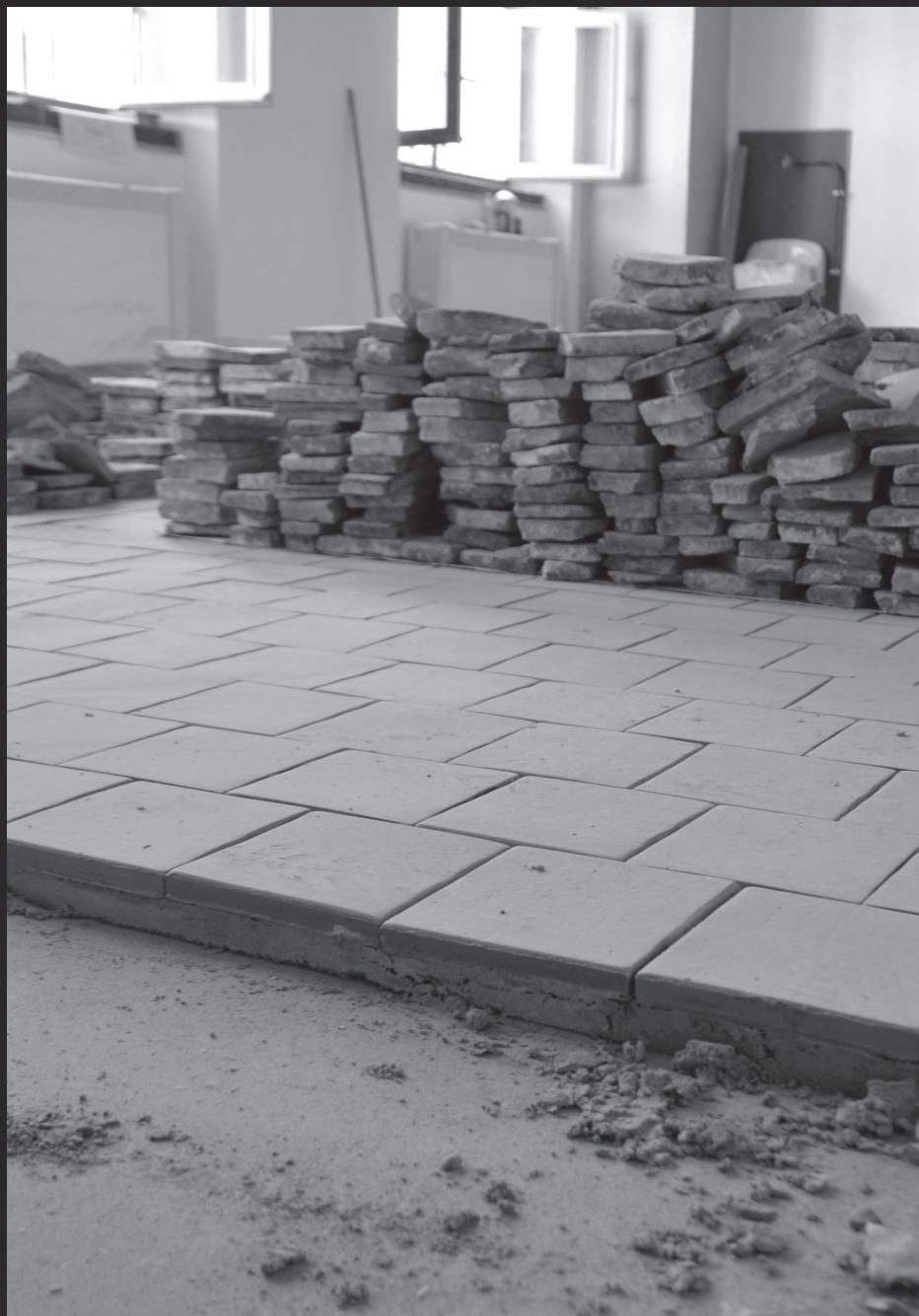
Placement des tomettes dans l'ancien coffre-fort.
